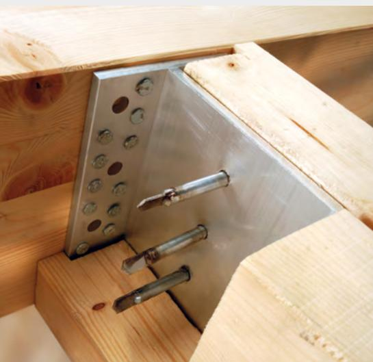
**Ausführung:** HECO-WS Stabdübel, Zylindersenkopf
